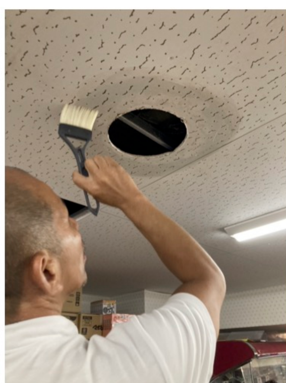
店舗の天井の低さにより冷気が店内に充満、換気が追いつかず天井との温度差により結露しカビが繁殖！
