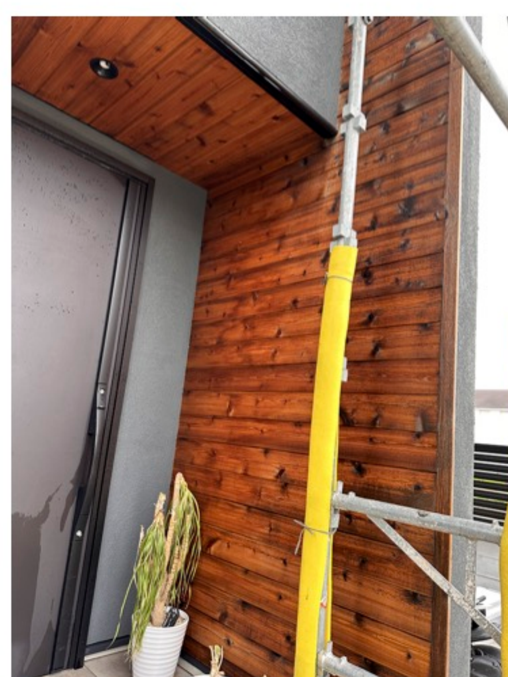
薬剤で洗浄➡ アクやカビなどを除去後、木の色を戻す➡ 乾燥させる➡ 長期間抑制のためコーティング
