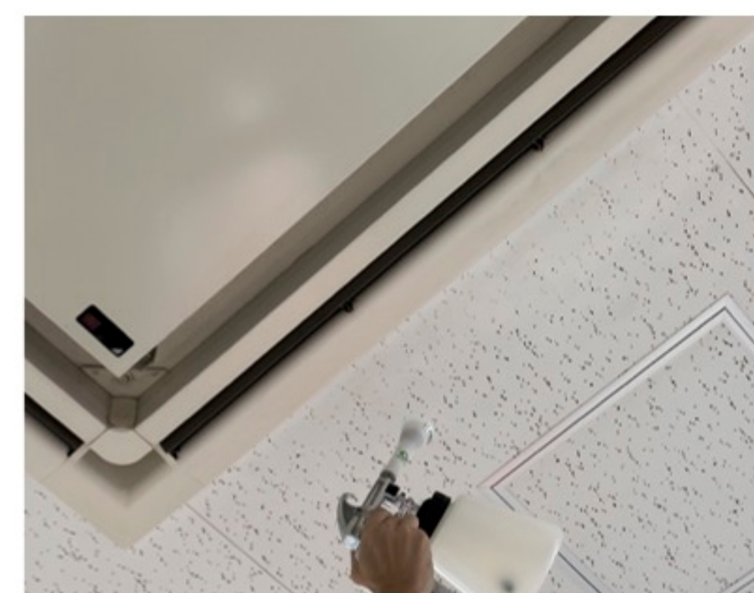
乾燥したらカビの発生 を長期間抑制のための コーティング。
