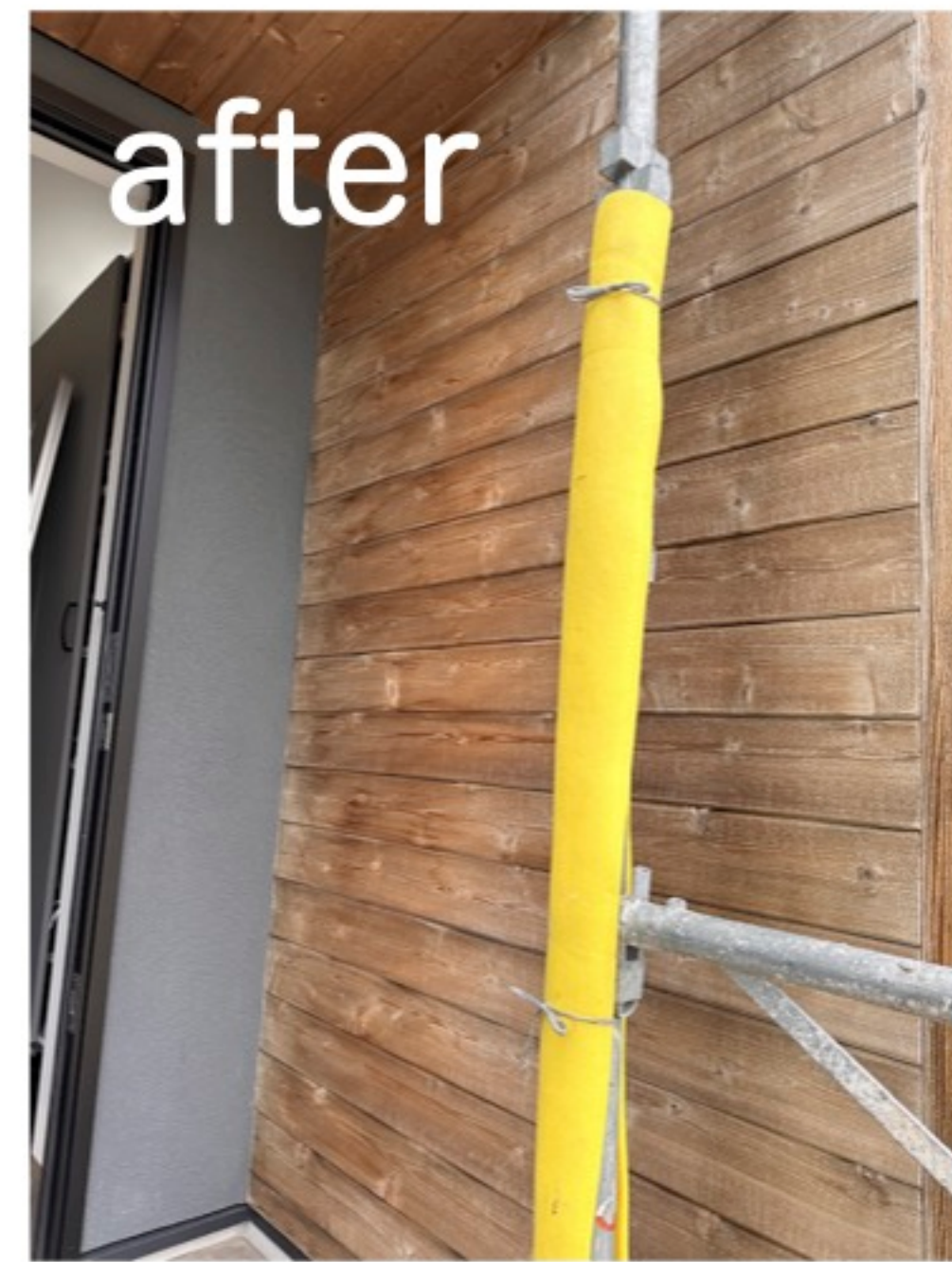
薬剤で洗浄➡ アクやカビなどを除去後、木の色を戻す➡ 乾燥させる➡ 長期間抑制のためコーティング
