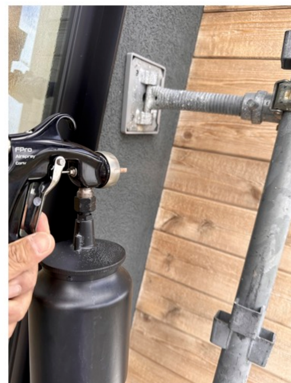
薬剤で洗浄➡ アクやカビなどを除去後、木の色を戻す➡ 乾燥させる➡ 長期間抑制のためコーティング
