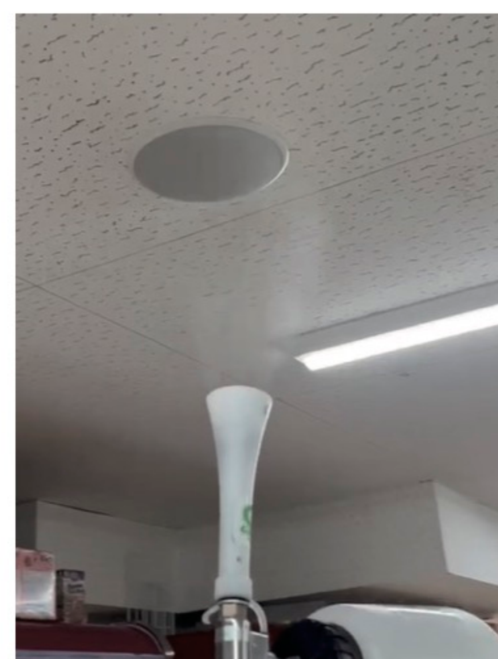
店舗の天井の低さにより冷気が店内に充満、換気が追いつかず天井との温度差により結露しカビが繁殖！
