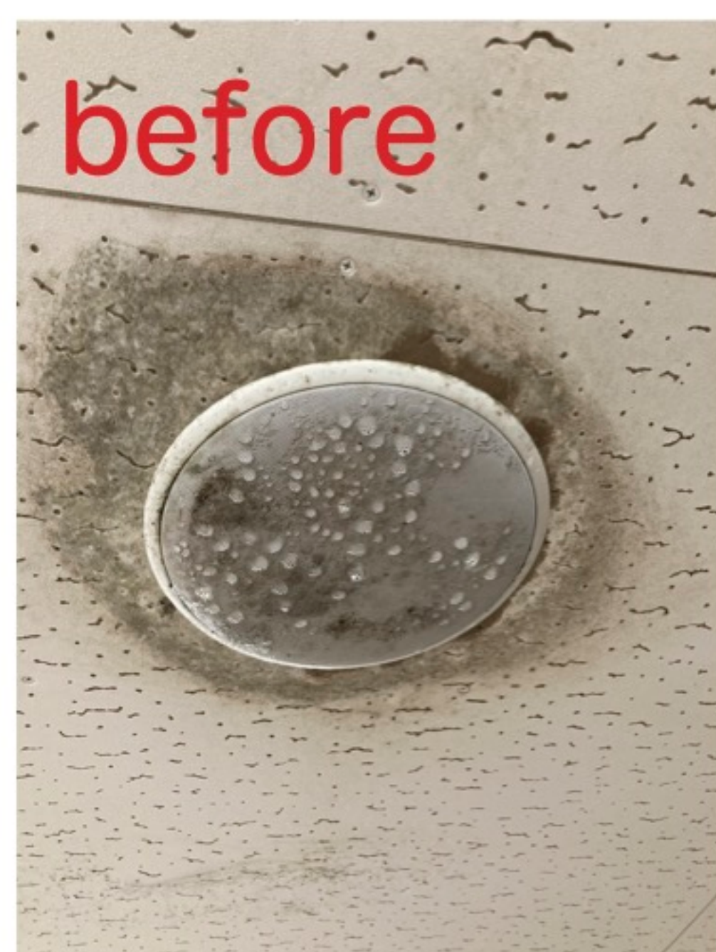
店舗の天井の低さにより冷気が店内に充満、換気が追いつかず天井との温度差により結露しカビが繁殖！
